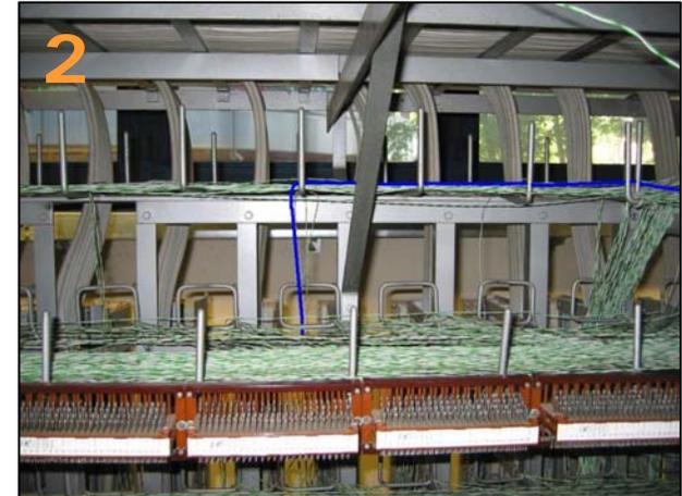
**Der Draht wird von der Rangierbrücke zur Trennleiste 71 hinabgeführt.**
